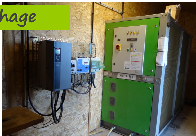
^ Installation du déshumidificateur
